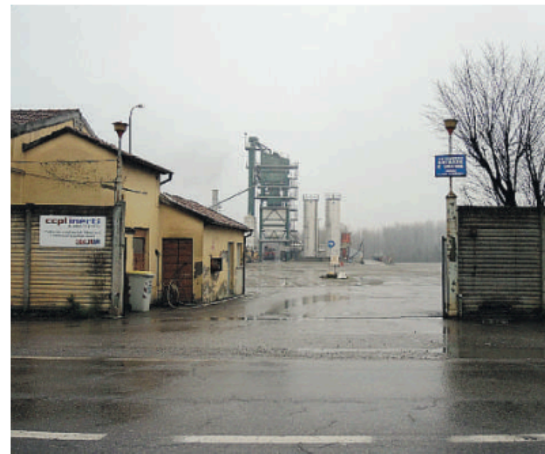
L'impianto di trattamento inerti che ora si trova a San Nicolò
