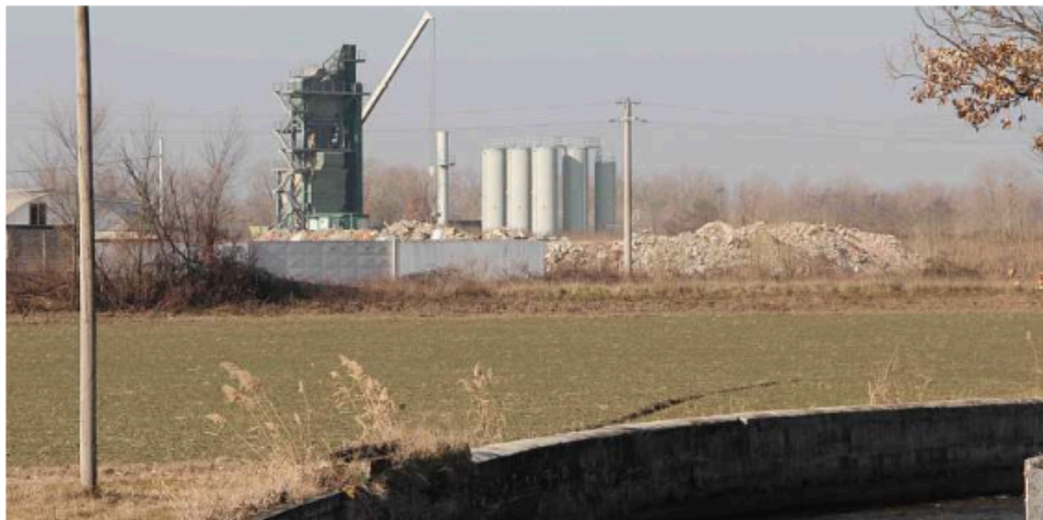
L'area di Pontenuovo dove è in corso di costruzione l'impianto di trattamento del bitume
