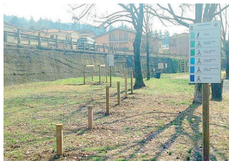
Proseguono i lavori di riqualificazione lungo il Trebbia a Rivergaro
