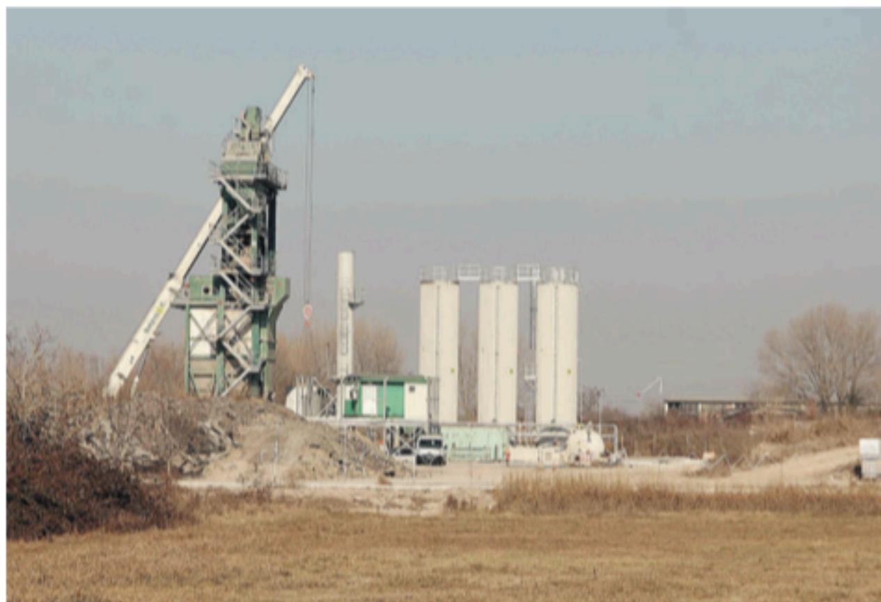
L'area di Pontenuovo in cui è in corso la realizzazione dell'impianto per il trattamento del bitume
