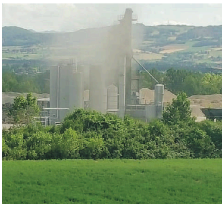
L'impianto di conglomerati bituminosi
